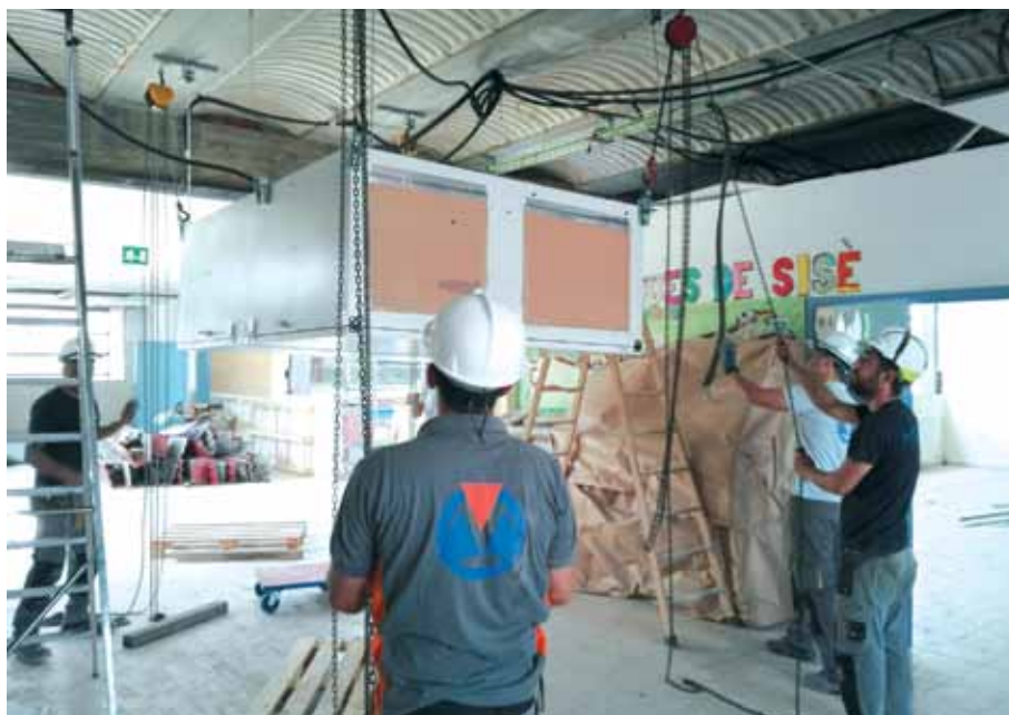
Colocación de la máquina de ventilación.
