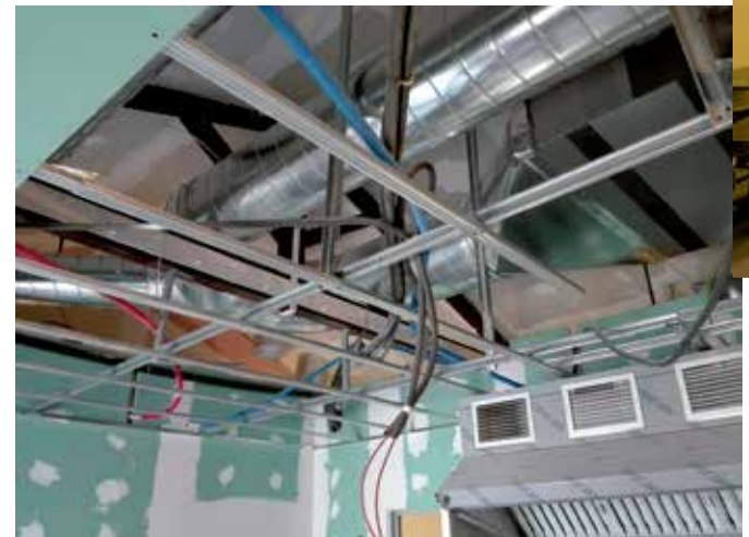
Ejecución del sistema de ventilación y clima.
