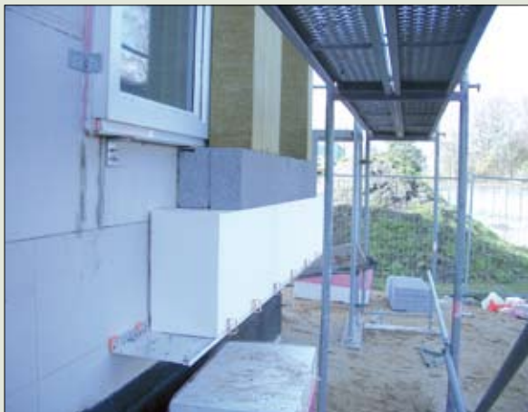
Los edificios están construidos con alto aislamiento térmico (30 cm de grosor), ventanas con triple cámara con valores U de 0,8 W/m 2 k y con una estanqueidad de los cerramientos muy alta de 0,22/h (50pa).
