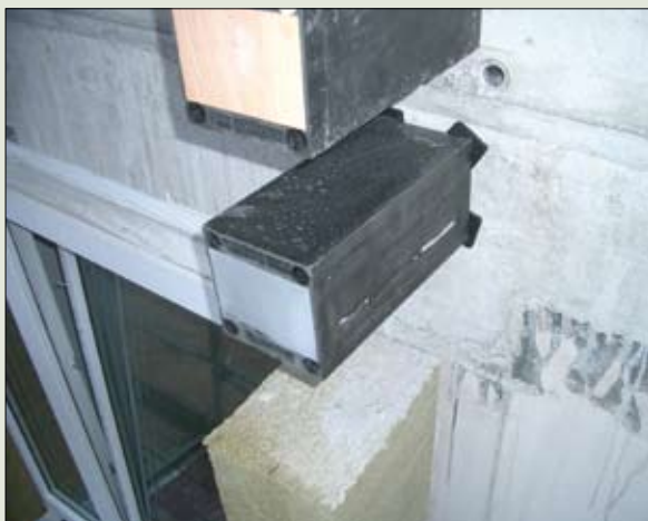
Consola de gran carga para la fijación de los balcones.
